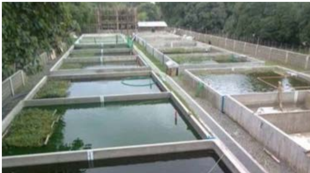
Tanques de alvenaria
