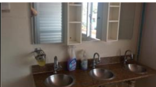
Banheiro. Foto: F. Tozzi, 2018.
