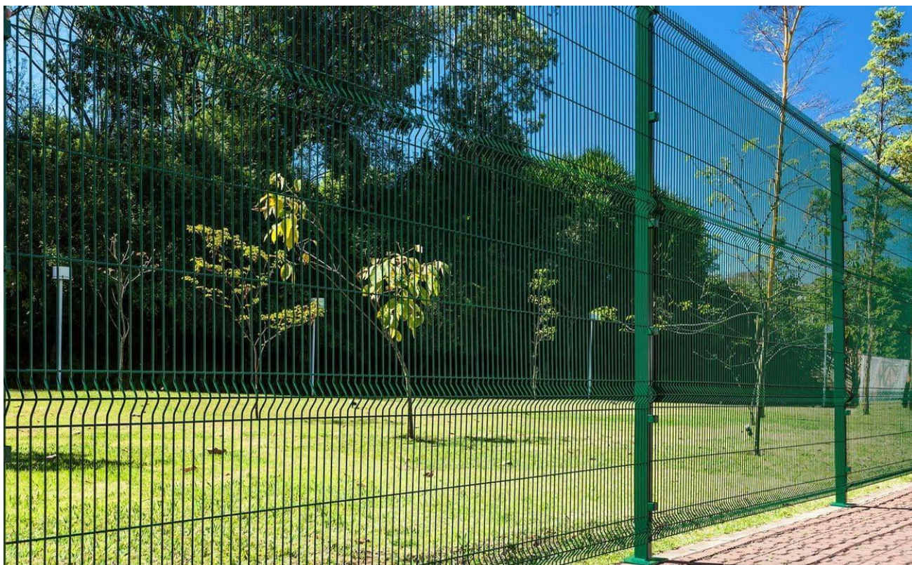
Figura 4: Modelo de Gradil de proteção da usina solar
