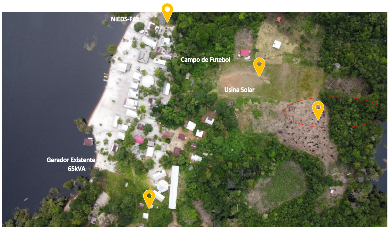
Figura 2: Localização da área prevista para instalação da USFV – Vila Três Unidos, área preparada para usina solar (ao lado do campo de futebol)
