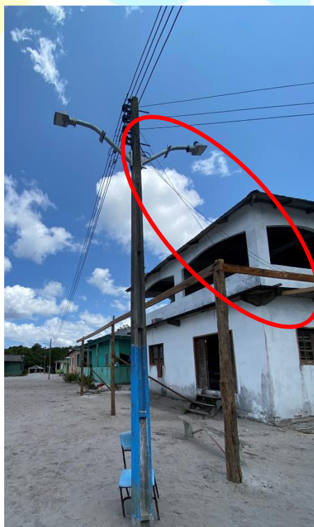
Foto 66 – Conexão das casas com o poste de distribuição
