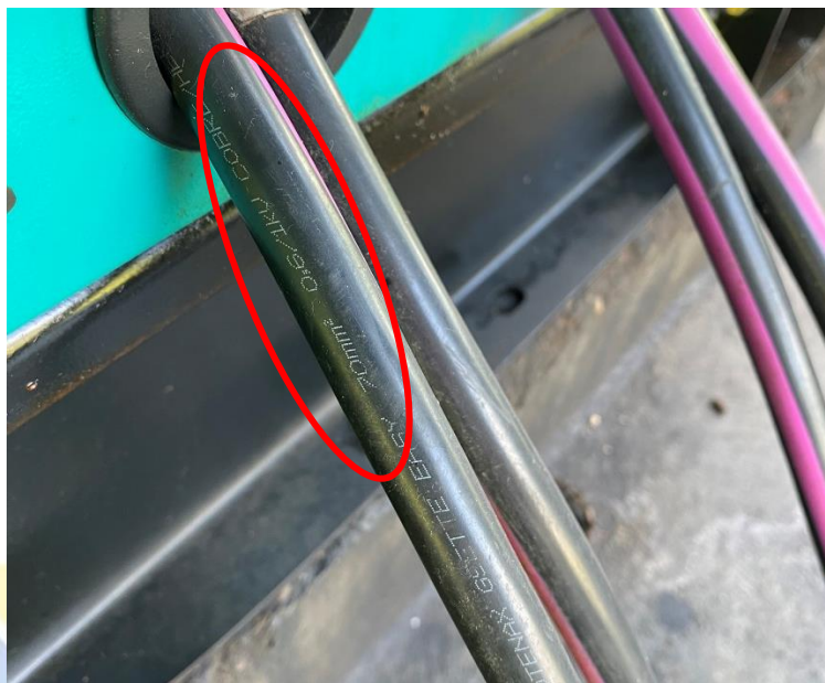
Foto 13 – Condutor de 70mm 2 0,6/1kV na saída do gerador de 75kVA até a chave blindada
