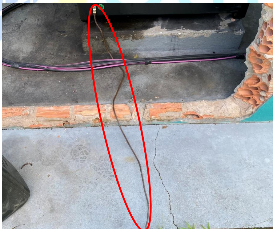
Foto 14 – Aterramento do gerador
