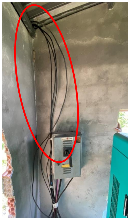
Foto 58 – Saída do circuito de distribuição aérea da chave blindada
