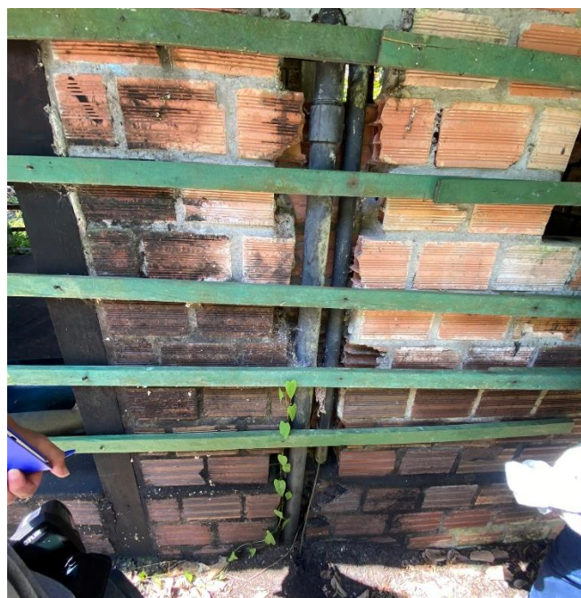
Foto 10 – Saída do circuito trifásico de distribuição para a caixa de passagem
