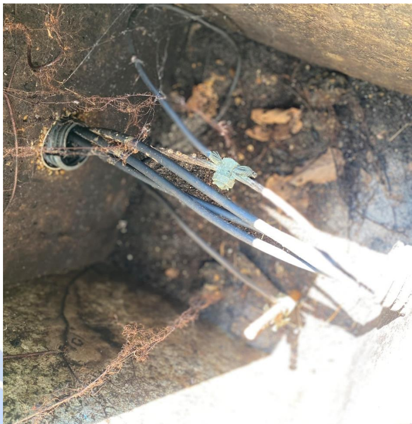
Foto 11 – Circuito trifásico passando pela caixa de passagem
