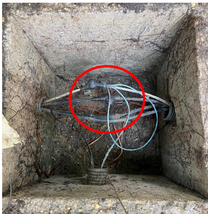
Foto 12 – Circuito de distribuição do gerador passando pela penúltima caixa subterrânea
