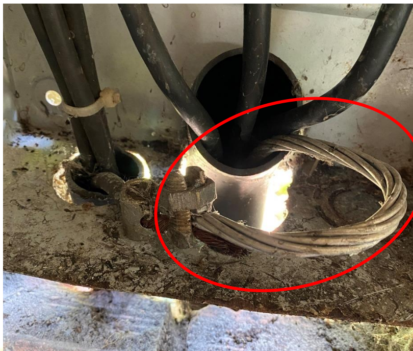
Foto 68 – Condutor tipo alumínio usado para aterramento da chave blindada
