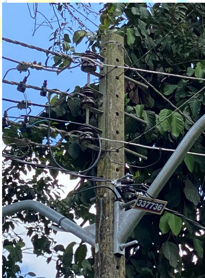
Foto 62 – Isoladores em poste de concreto
