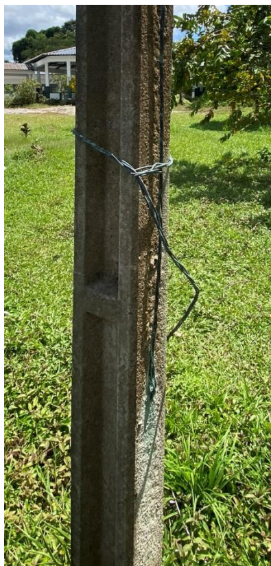
Foto 70 – Condutor de aterramento rompido
