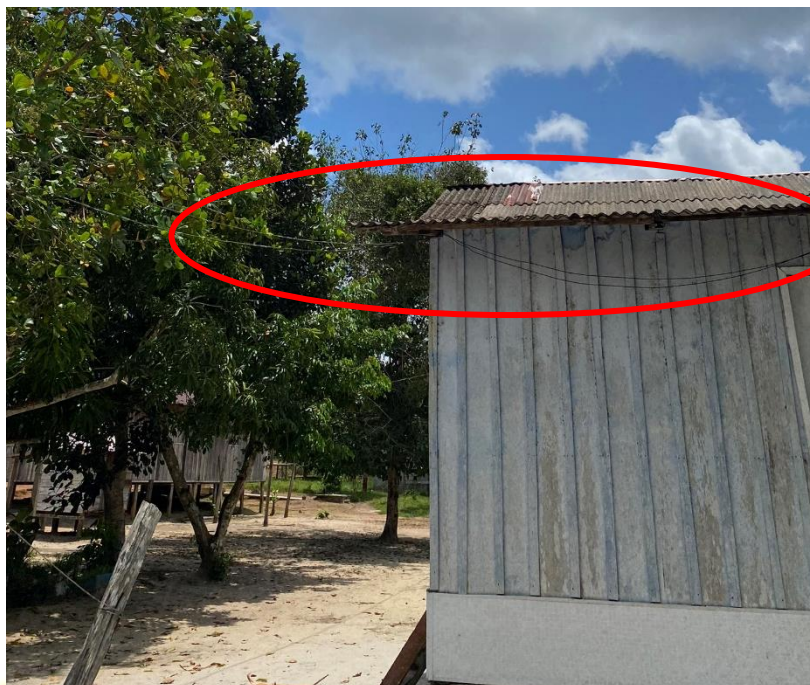
Foto 67 – Conexão das casas com o poste de distribuição
