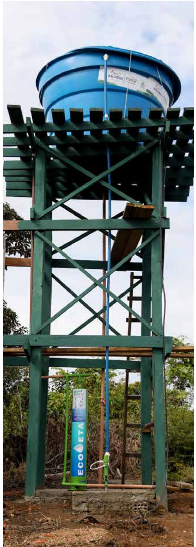
Na Comunidade do Tumbira, na Reserva de Desenvolvimento Sustentável (RDS) do Rio Negro, sistema de abastecimento de água potável movido a energia solar transformou a vida das famílias locais, 2025 – Foto: Michael Dantas
