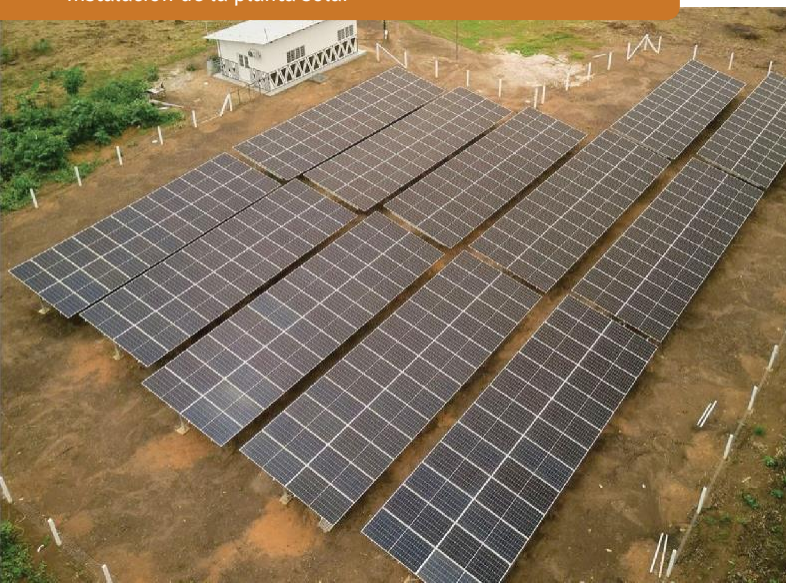
Instalación de la planta solar
